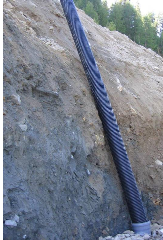
Figura 6. Montarea drenului
