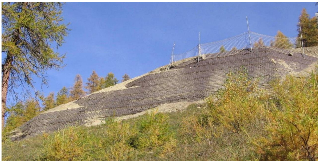
Figura 9. Finalizarea masivului de Textomur
