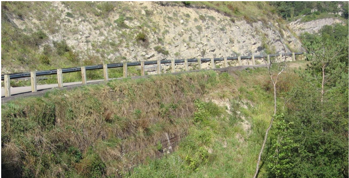
Figura 2. Lucrarea realizată în Franța cu textomur vegetal
