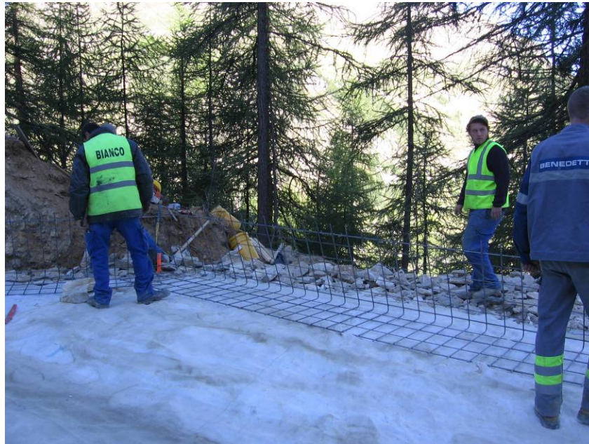
Figura 10. Pozarea cofrajului metalic
